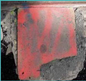
Avec les plaques métalliques
