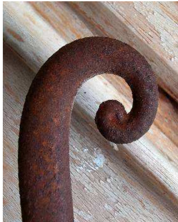
Grilles en métal ouvragé
