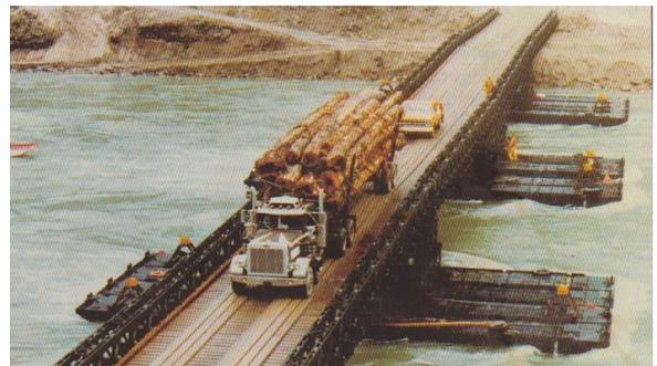
Le pont Bailey repose en général sur des supports fixes tels que culées de rive ou piles intermédiaires mais peut également être soutenu par des **supports flottants** ou **suspendu** à des pylônes.
