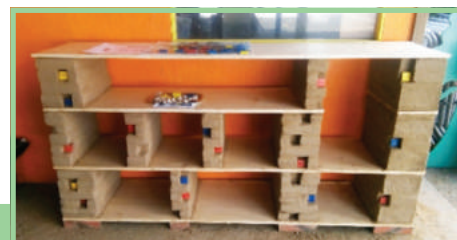
Réalisation du banc en terre crue
