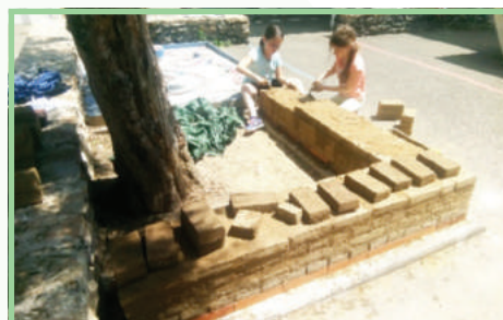
Réalisation du banc en terre crue
